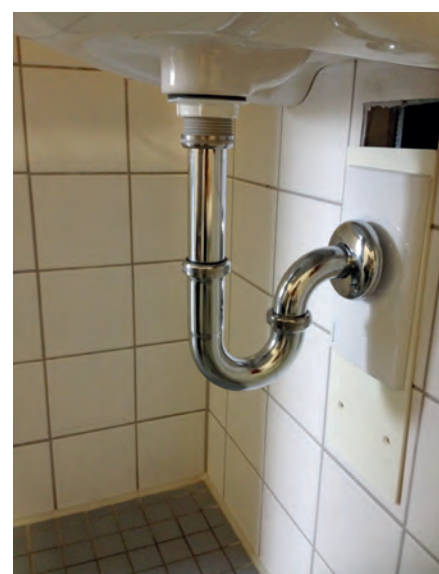
Figure 2 : Bonde d'évacuation en forme de S.
