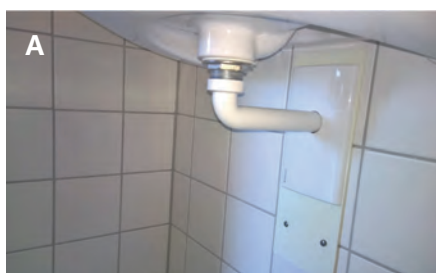
Abbildung 1: A: L-förmiger Siphon und B: Flaches Waschbecken der Rehabilitationsstation.
